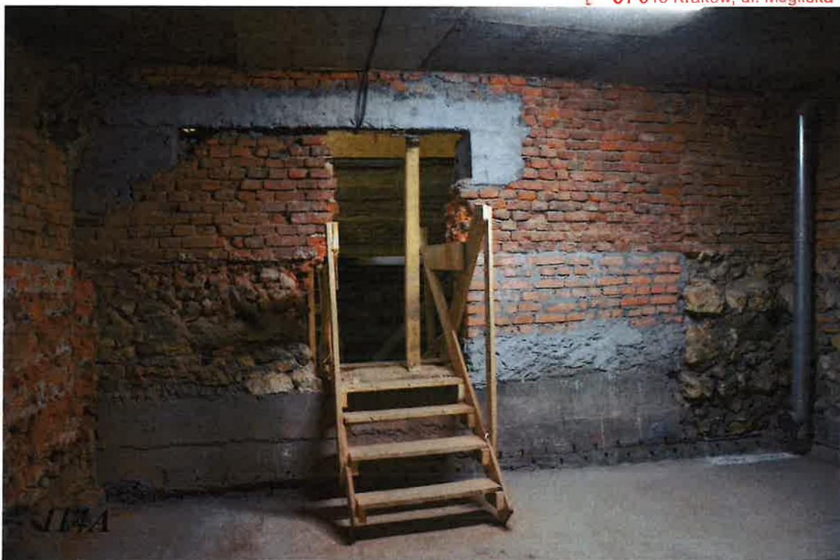
Część podziemna po wykonaniu podbić fundamentów
